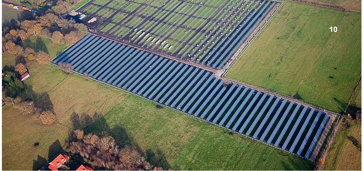
In Tweelbäke entsteht bis Ende 2011 ein Solarpark mit 4,4 MW Leistung. TEXT/FOTO: TORSTEN THOMAS/JOCHEN KLEIN
